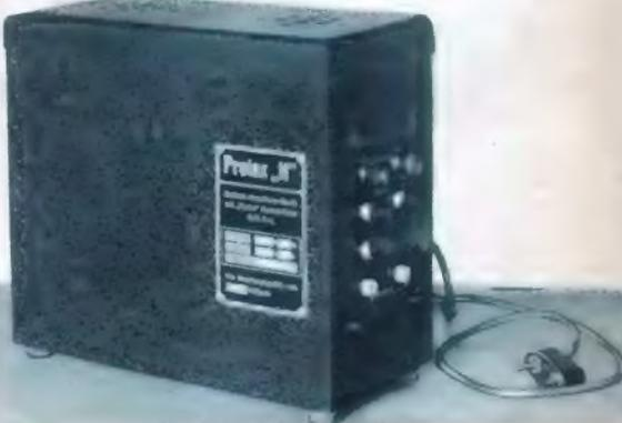
Ein Heizanschlußgerät für Wechselstrom: Akku mit Kleinlader in gemeinsamem Gehäuse.
